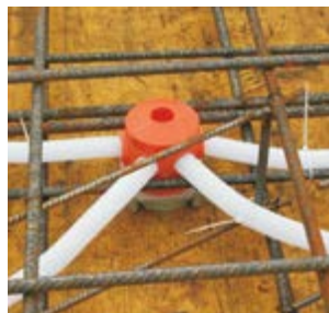
Пример установки в горизонтальной опалубке.
