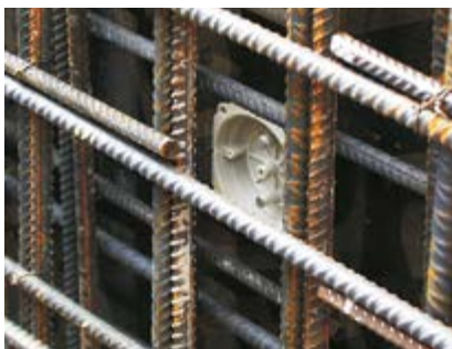
Крышка KBV, прикрепленная на опалубке.
