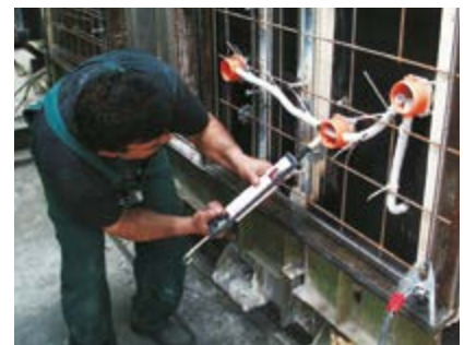
Герметизация вводов (отверстий).
